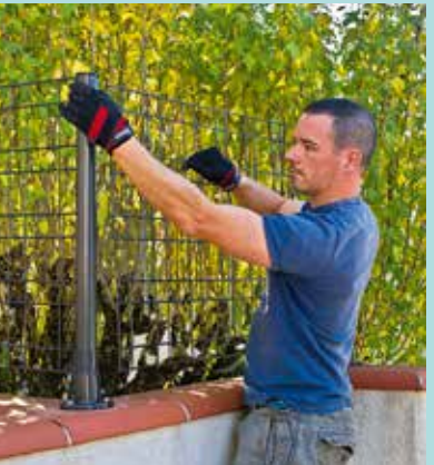
16 Au niveau du poteau d'angle, effectuez une rotation (45°) des colliers pour insérer le dernier panneau découpé. Vissez les colliers et solidarisez le dernier poteau à sa platine.
