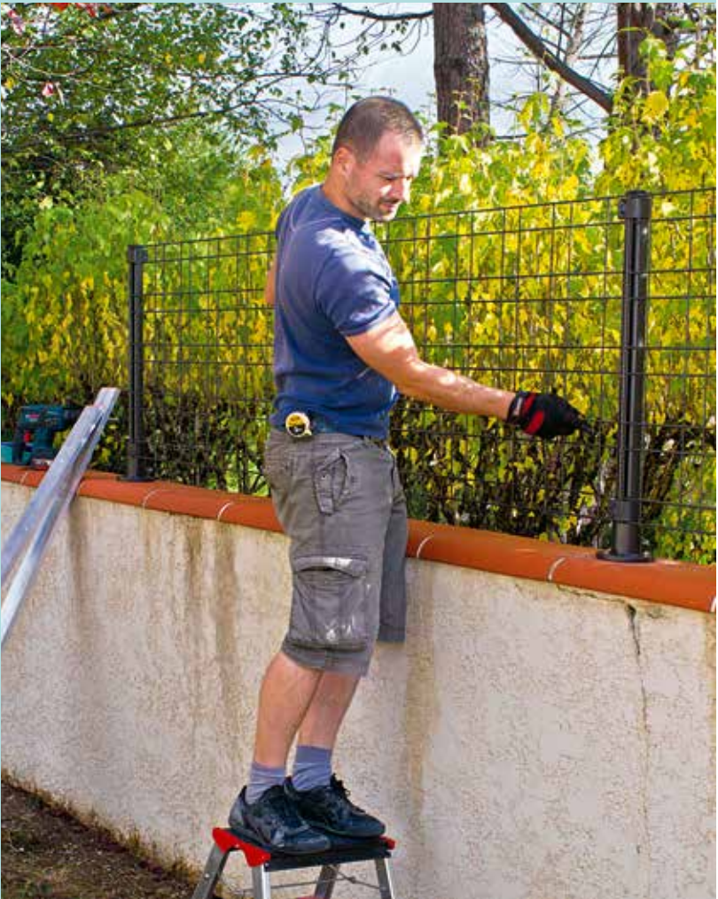
12 Préparez un troisième poteau et un deuxième panneau grillagé comme précédemment, puis placez-le sur le poteau déjà en place. Vérifiez l'alignement puis percez, chevillez et vissez la troisième platine. Continuez ainsi.
