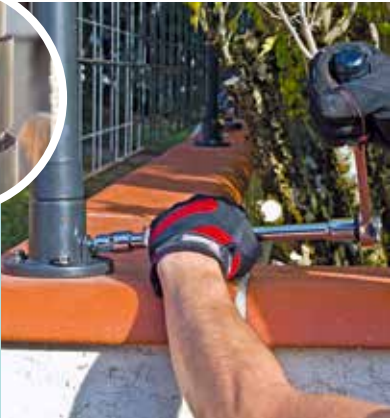
14 À l'aide d'une clé à douille à cliquet (Ø 13 mm) ou d'une clé plate, vissez la base de chacun des poteaux sur leur platine respective.
