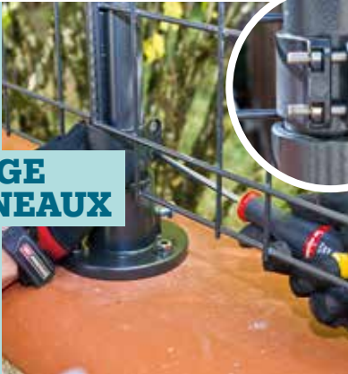
13 Lorsque toutes les sections poteaux/panneaux sont en places, vissez chaque collier sur son poteau après avoir glissé un écrou dans le logement dédié.
