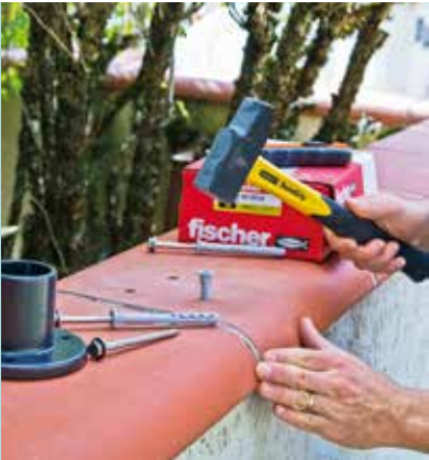
9 À l'aide d'un marteau, insérez une cheville dans chaque trou de fixation jusqu'en butée de collerette.
