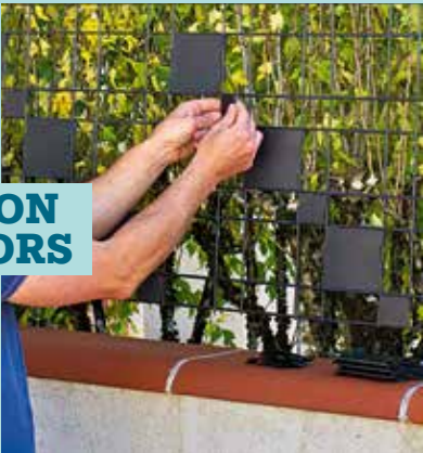
17 Pour personnaliser les panneaux de clôture, des modules en PVC s'insèrent entre les espaces formés par les fils soudés du maillage.
