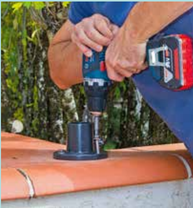
11 Remplacez les platines. Positionnez la vis de maintien du poteau côté intérieur du muret (plus esthétique). Vissez les fixations à la visseuse équipée d'un embout Torx.
