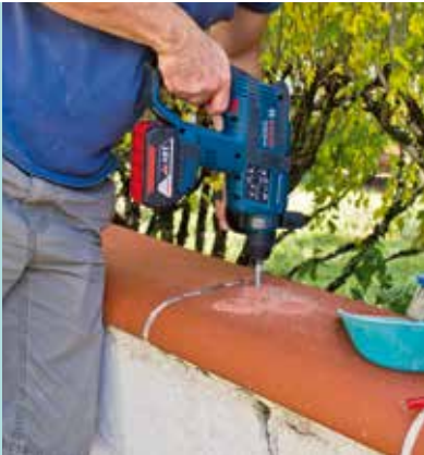
8 Retirez l'ensemble des pièces puis à l'aide d'un perforateur équipé d'une mèche à béton (Ø 10 mm) percez selon les repères. Dépoussiérez aux abords des trous.
