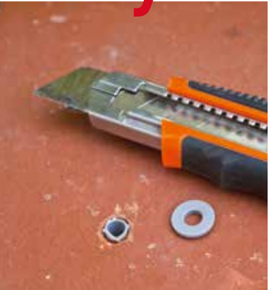
10 Comme le socle de la platine n'est pas creux, sectionnez au cutter la collerette afin que le haut de la cheville affleure la surface et ne gêne pas son positionnement.
