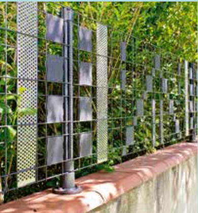
19 Glissez dans le maillage du panneau les bandes métalliques. Pour les maintenir en place, utilisez du fil métallique passé à travers les trous de la bande.
