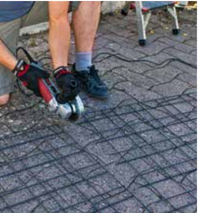
15 En bout de muret, mesurez l'entraxe restant au mètre ruban, puis recoupez à la meuleuse équipée d'un disque pour métal la section de panneau correspondant.
